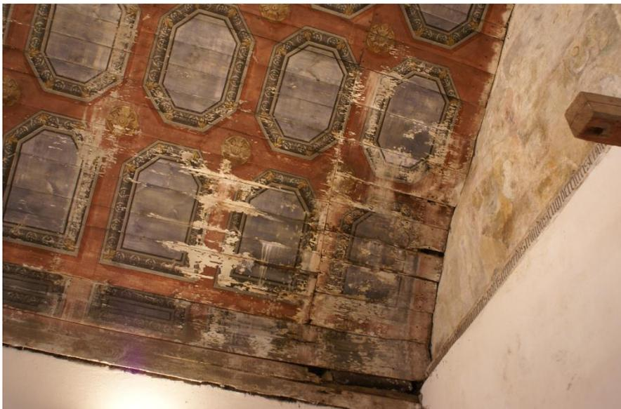
Das Bild (Foto Tillwick) zeigt die Südwestecke, eine der am meisten geschädigten Stellen der Holztonne. Hier war in der Sowchos-Zeit zwischen Turm und Dachansatz viel Wasser eingedrungen. Diese Lücke ist seit der Dacherneuerung 2012 abgedichtet.
